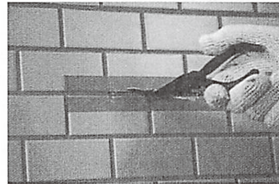
写真3 タイルフィックスの埋込み
